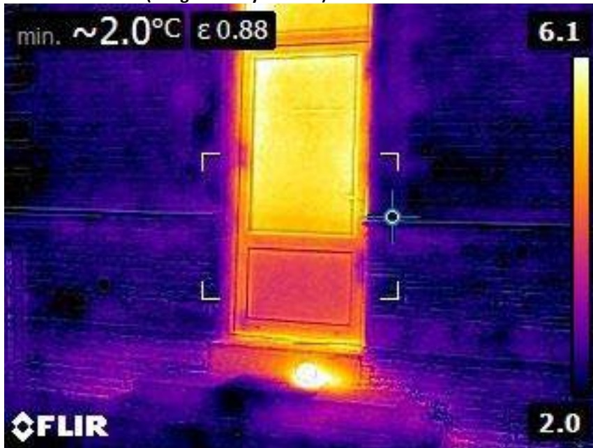
Mur extérieur avec ThermaCote
