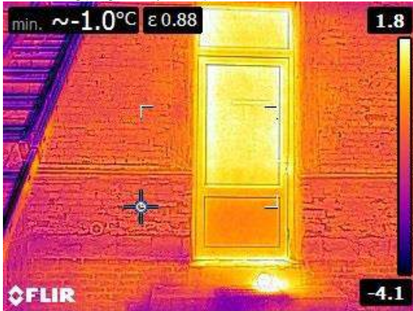
Mur extérieur avant application
